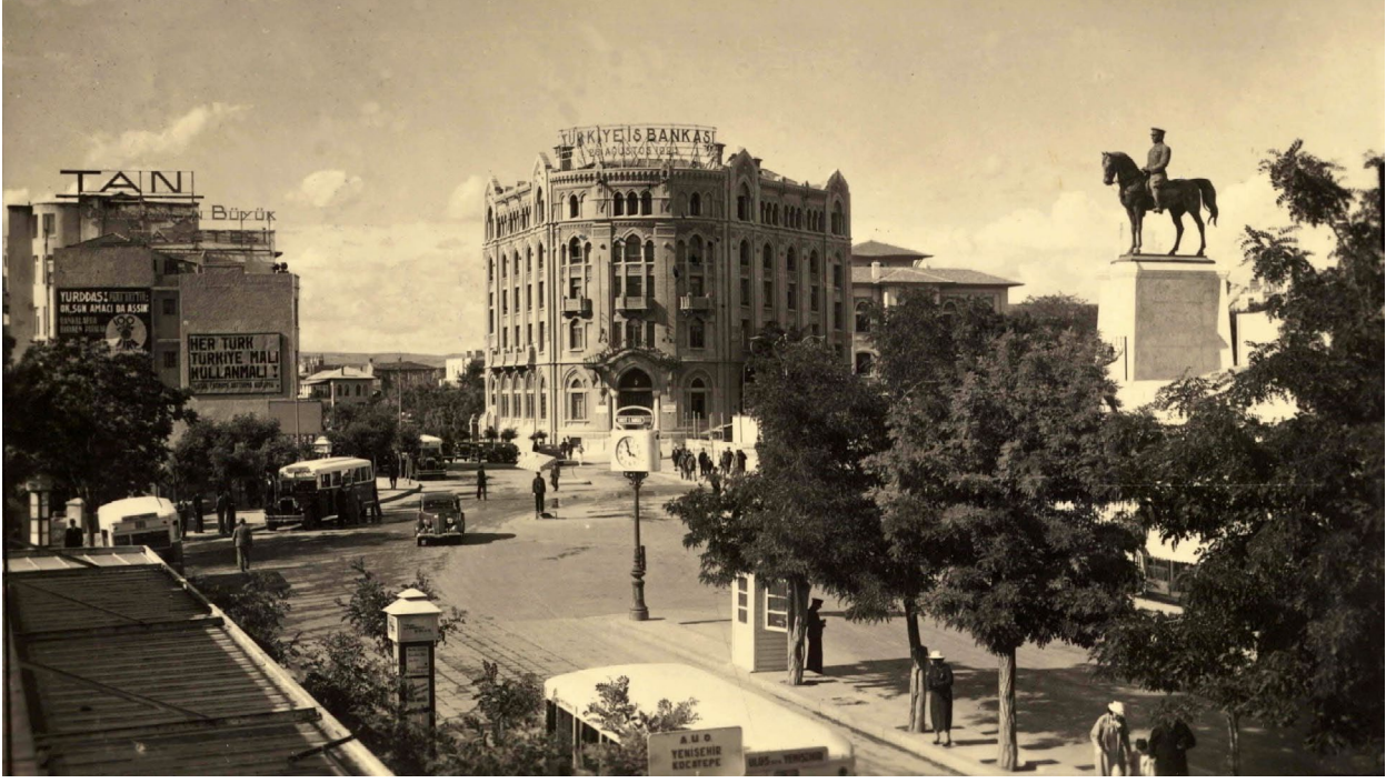
Şekil 2. Hakimiyet-i Milliye Meydanı (Ulus Meydanı), İş Bankası Genel Müdürlük Binası (Giulio Mongeri, 1926-1929). Sağda Zafer Anıtı (Atatürk Anıtı, Heinrich Krippel, 1927). Kaynak: Koleksiyoncular Derneği, Keskinok, 2009, s. 139.
